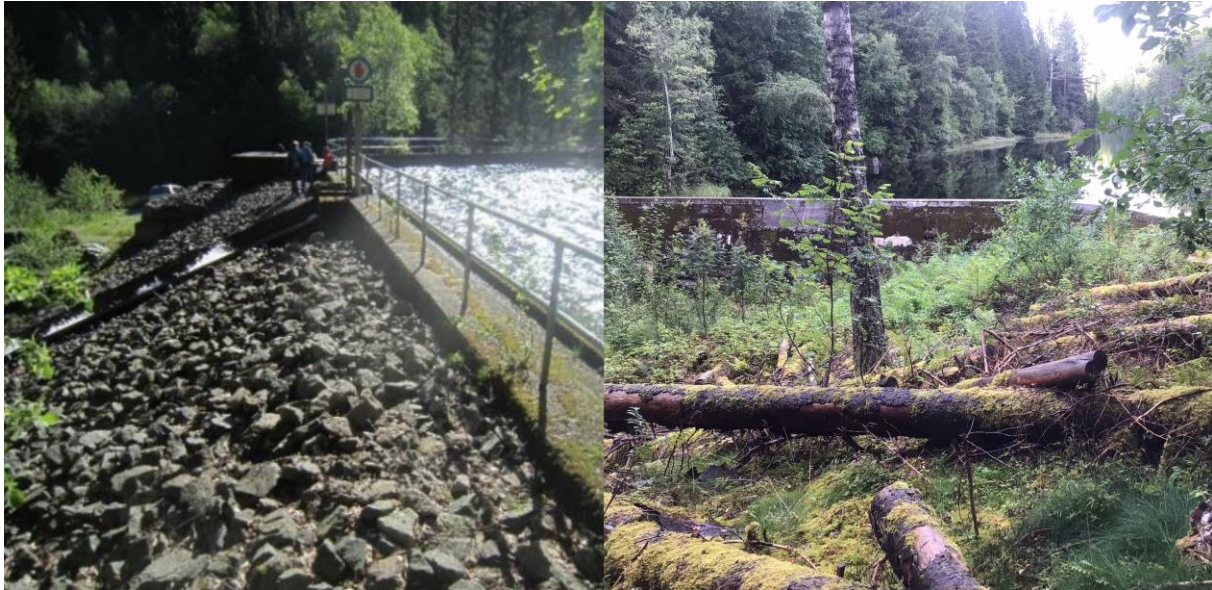
Figur 2.3. Dammer ved Åmotdammen. Venstre: Hoveddam. Høyre: Sperredam vest
